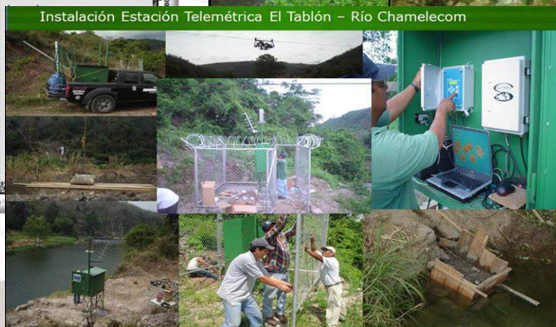
Instalación Estación Telemétrica El Tablón - Río Chamelecom
